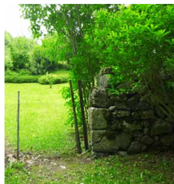
Montesquieu Avantès: Pour avoir une extrémité de muret résistante, de gros blocs y ont été intégrés c'est ce que l'on appelle une chaîne d'angle.
