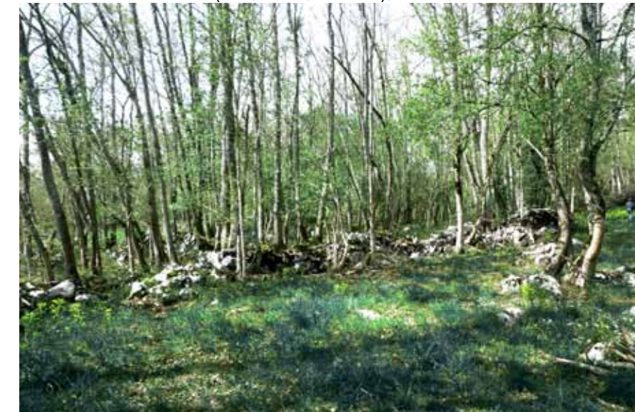
Muret «malade» en lisière: là où la végétation progresse les murets s'étiolent - Les Quères (au nord de Bouch)
