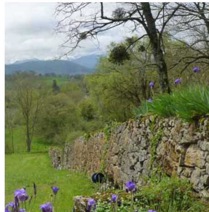
1- Structuré (pierres taillées)
